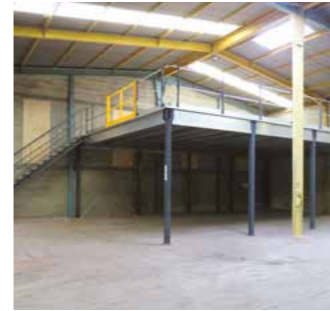
Plateforme de stockage
